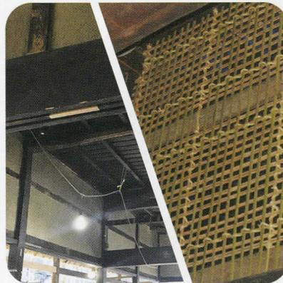
古民家は、砂利の上に礎石という石が置かれ、その上に土台と柱が載っていたようです。今回の修復ではその建築方法が再現されています。とはいっても現在の建築基準法にも合わせて基礎の部分は鉄筋コンクリートで新設してあります。
