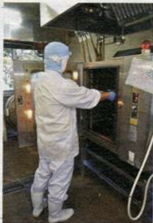
蒸す・焼くが1台できる「スチームコンベクション」 葛飾区立清和小学校調理室
