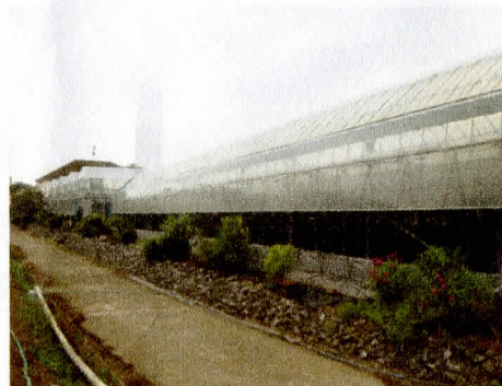
高品質・安定生産のため導入した雨除けハウス
