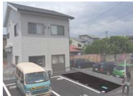
写真2 庭先販売所を建設する敷地
