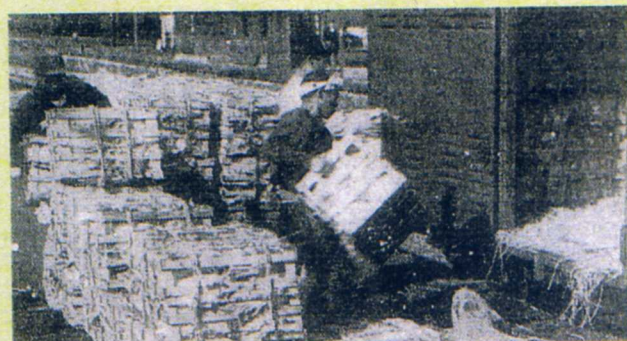
昭和14年の岩切駅出荷風景(昭和14年10月7日付「河北新報」より)
