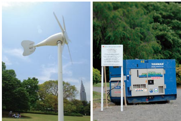
上左／新宿御苑展ではお馴染みのニッコーの小型風力発電システムが今年も登場。上右／廃油をリユースするバイオディーゼル発電機。会場の多くの電力をまかなう。右／資源米を利用したライスポリ製のゴミ袋。CO 2 排出量は通常のゴミ袋に比べて30%削減される。
